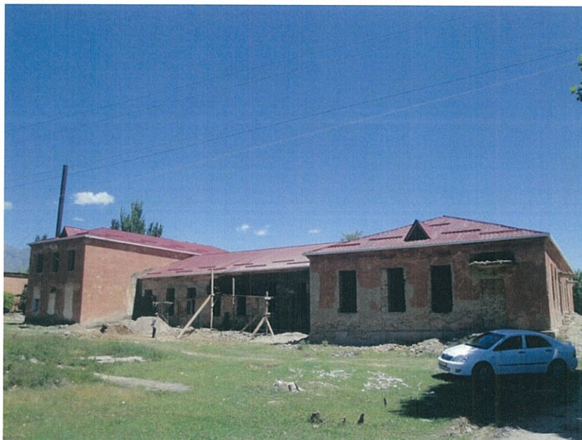
写真 1 改修工事中の、バフダットリハビリセンターの建物外観 (2013 年 5 月 30 日、バフダット)
