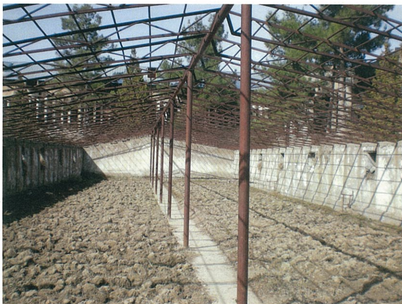
写真 7 : ヒッサール寄宿舍学校内の修繕される前の温室 (2011 年 5 月 20 日)
