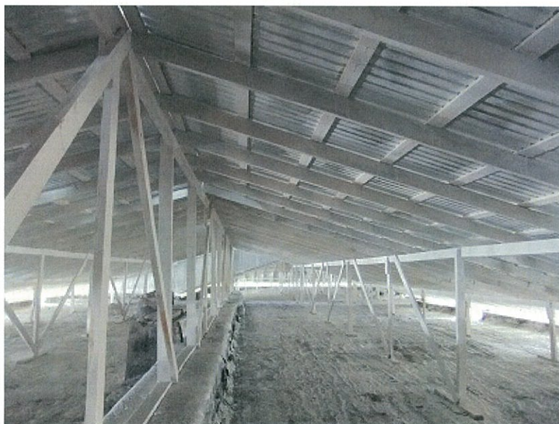
写真 5：修繕されたヒッサール寄宿舎学校の屋根（2012 年 4 月 6 日、ヒッサール）
