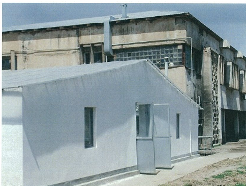
写真 8 : ヒッサール寄宿舍学校内の修繕された温室 (2012 年 4 月 6 日、ヒッサール)
