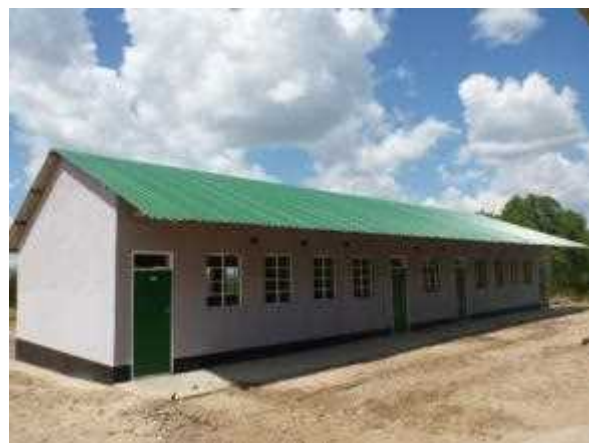
完成したニューメイン小学校の校舎 (2014年3月撮影)
