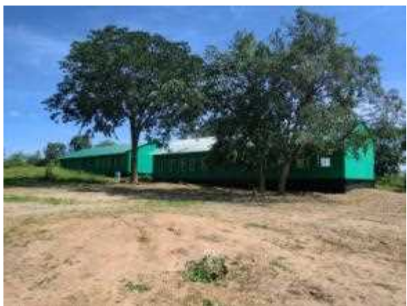
完成したガンガンガ小学校の校舎 (2014年3月撮影)
