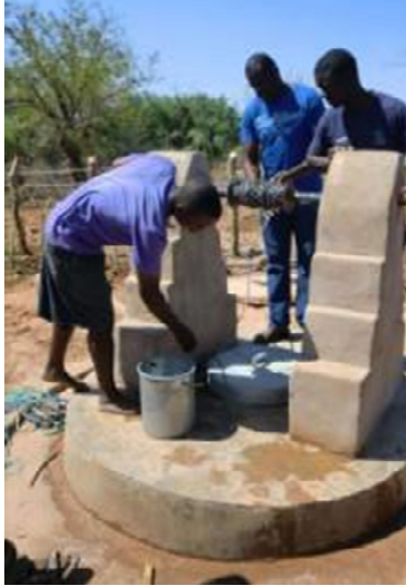
完成した浅井戸（2013 年 10 月撮影）
