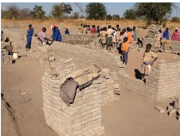
住民がつくったレンガを積み上げて校舎の土台をつくっている様子 (2013年7月撮影)
