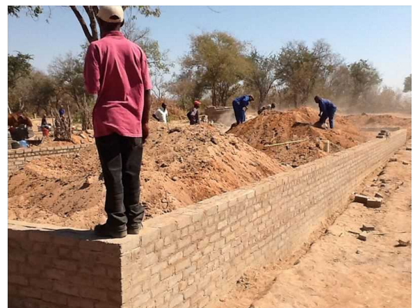
校舎の土台に土を入れている様子 (2013年7月撮影)
