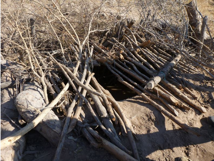
村の浅井戸。井戸にふたなどがなくきちんと整備されていない。
