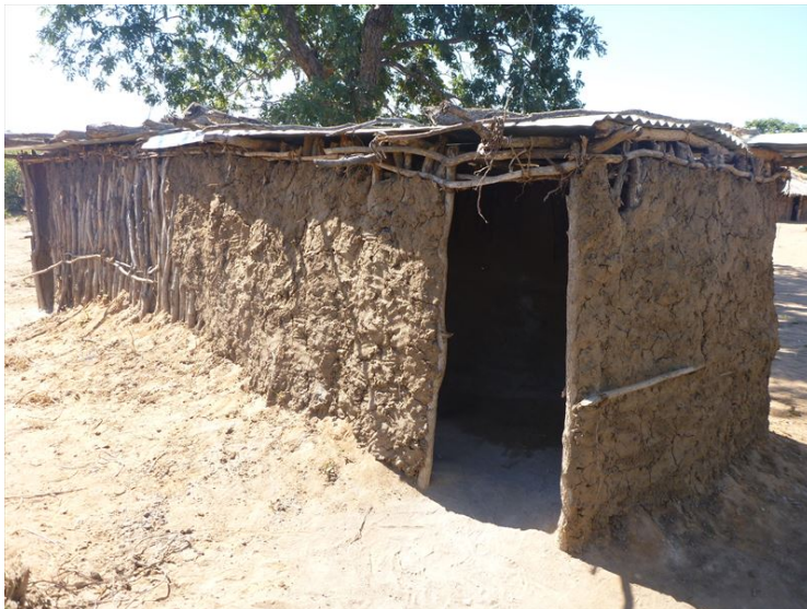
衛生的ではない小学校のトイレ。(なお、トイレのない学校もある。)
