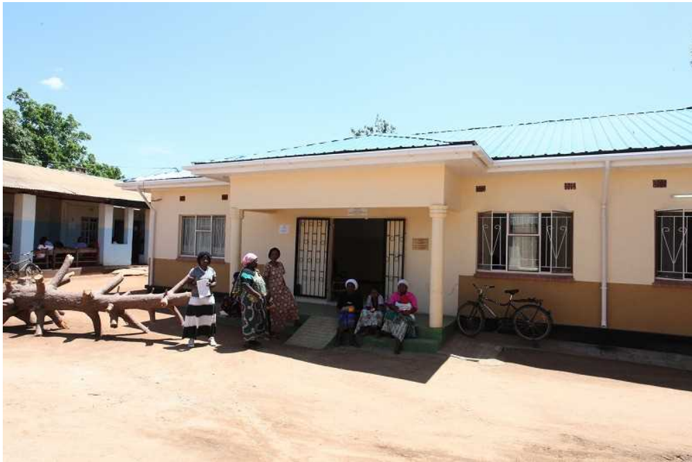
【写真①】 完成したマウントマクル・クリニックの ART センター (2013年11月26日 マウントマクル・クリニックにて)
