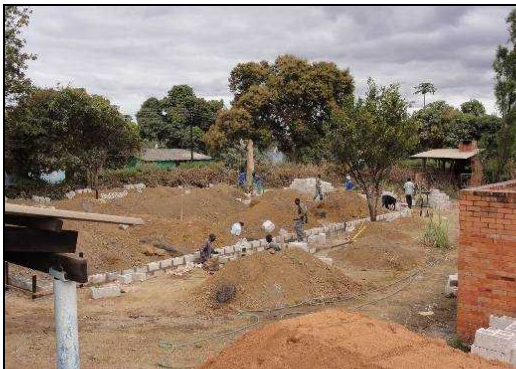
【写真②】 ナンゴングウェ・クリニックにおける ART センター基礎工事の様子。(2013年6月19日 ナンゴングウェ・クリニックにて)
