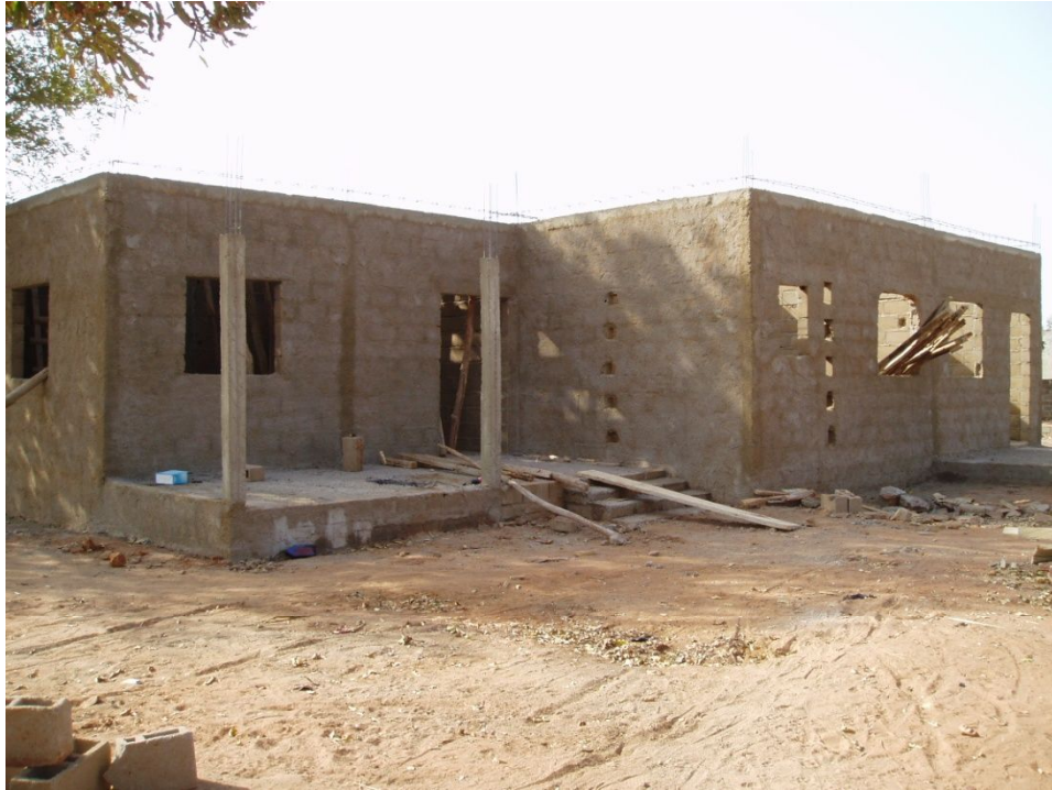
1月25日現在のスウバ村診療所建設状況
