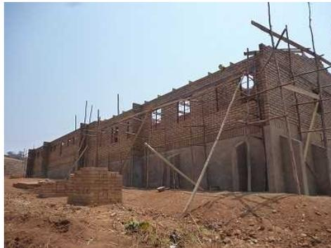
⑤ 屋根レベルまでの外壁工事完了
