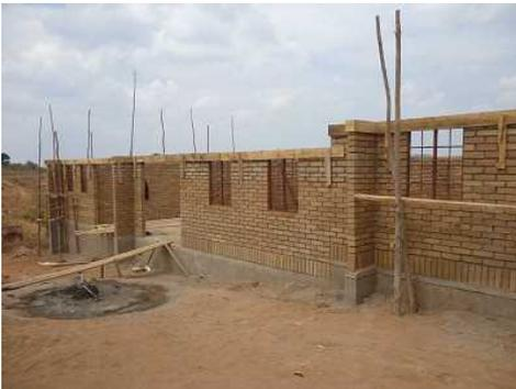
④ 窓枠レベルまでの外壁工事完了
