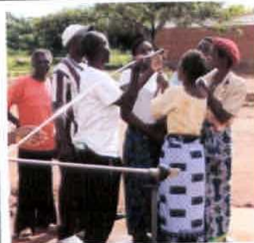
【写真 12】井戸管理・修繕講習会の現地練習で井戸の解体、組立を練習する委員会メンバー。
