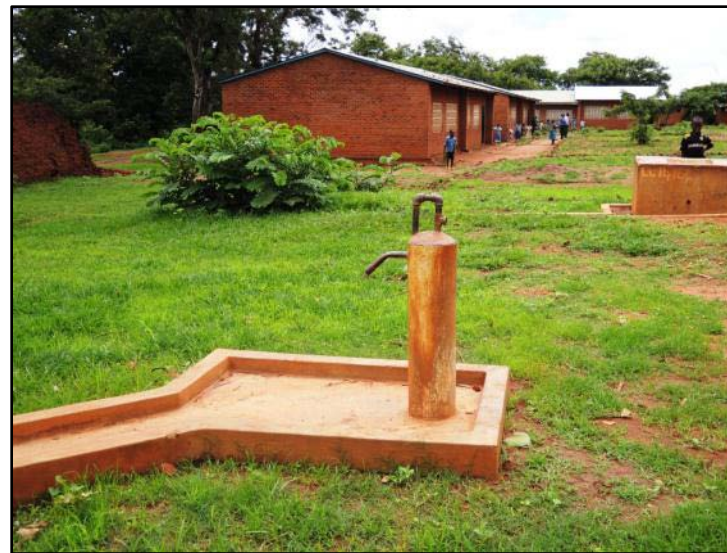
壊れたまま放置されている小学校の井戸。
