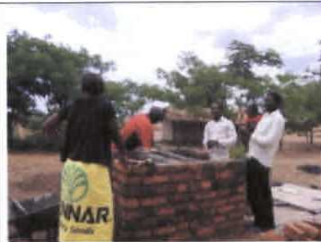
【写真8】建設中のエコサントイレ。現地スタッフJane（黄色のスカート）が建設工程をチェックしているところ。
