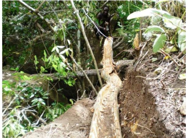
2012/03/03 チャンデ ソマ村 自力で完成させた灌漑施設、丸太を切り抜いて水の通り道を作成
