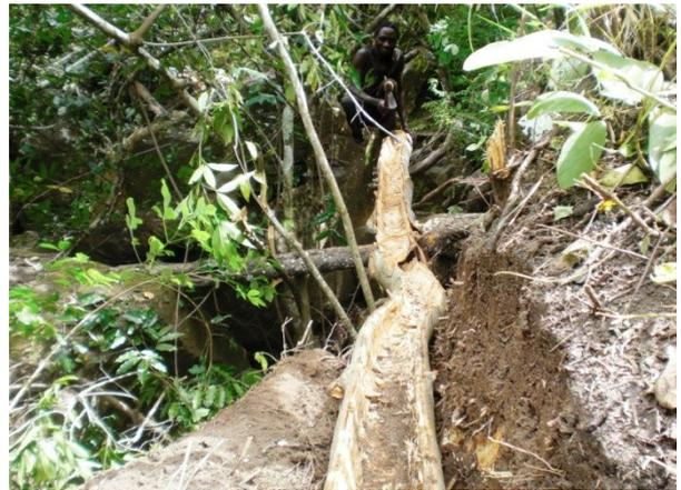
2012/03/03 チャンデ=ソコマ村 自力で完成させた灌漑施設、丸太を切り抜いて水の通り道を作成
