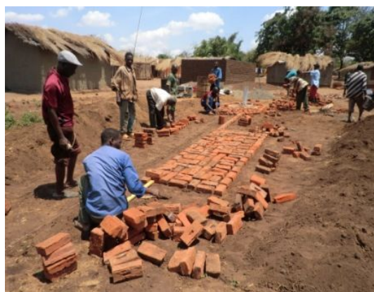
井戸の地上部の建設風景（Nkotamo 村）
