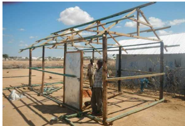
12. 仮設住宅の骨組みが完成
