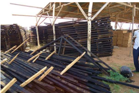
5. 屋根枠の完成品
