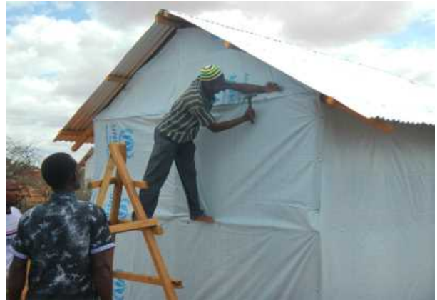
1 4. 壁となるシートの取り付け作業
