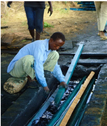
3. 建設用木材の防腐処理作業
