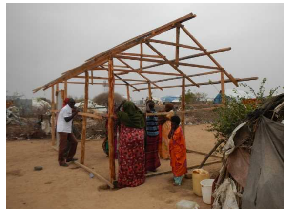
1 8. 建設中の仮設住宅でPWJ職員と話す受益者
