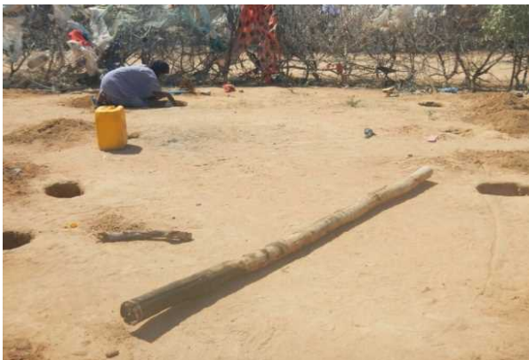
11. 受益者自ら支柱を立てる穴を掘る
