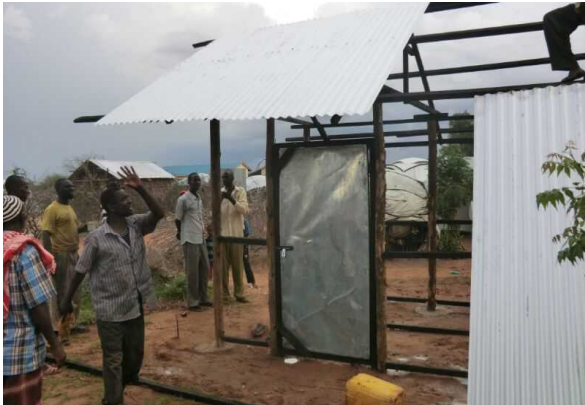
1 3. 屋根の取り付け作業
