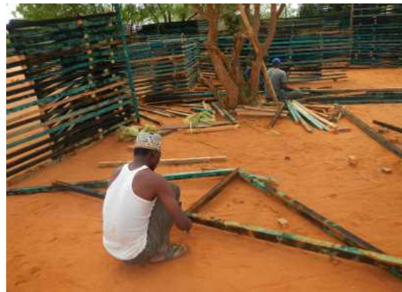
4. 屋根の枠組み作成作業
