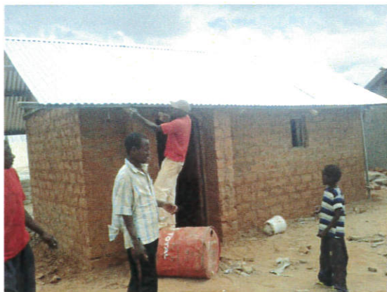
（仮設住宅の完成）
