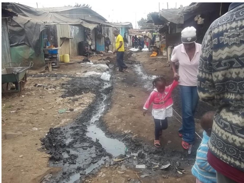
サウスランズにおける土嚢による路地・下水道修復活動
