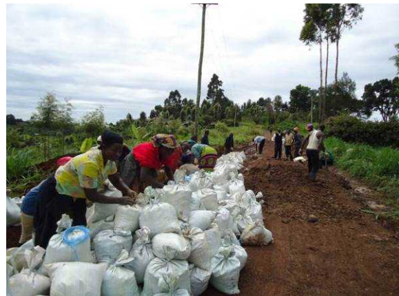
写真27 ガタマユ乳業組合 4月8日-5月24日 （9月12日） 集乳車がスタックする箇所87m を補修。
