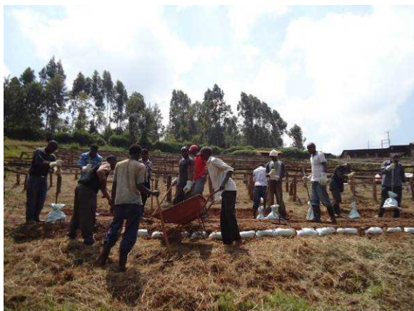
写真 28 キアンバーコーヒー生産組合グループⅠ 6月 3-7 日 (9 月 11 日) 舗装道路からコーヒー豆を貯蔵する倉庫までの取り付け道路 63mを補修。
