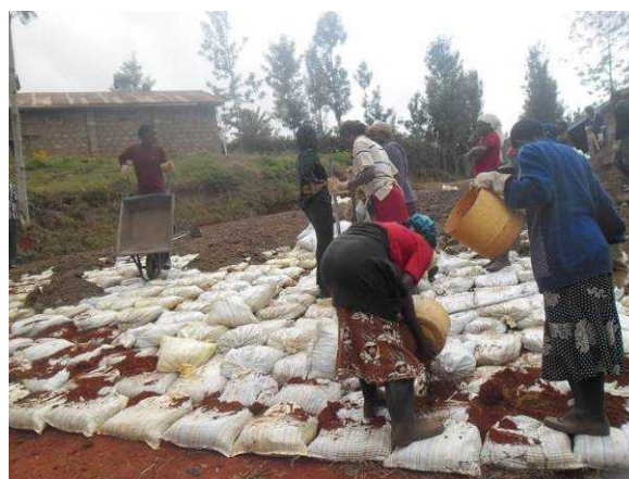
写真 31 キノゲラマコーヒー生産組合 7 月 22-26 日 コーヒー豆の集荷が行われる広場を補修。
