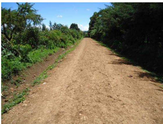
写真 16 チェプティレット：7月8-19日 施工後。小学校に続く通学路274mを補修。スクールバスが雨期でも楽に学校に到着できるようになった。
