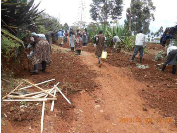
写真 12 エペソⅡ：3月20日-4月24日（8月14日） 小学校に隣接する農道100mを補修。
