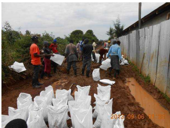
写真 20 フロントライングループ：9月 3-9 日 エルドレット近郊の小学校に隣接する通学路 105mを整備。道をかさ上げし。小学校の下水路を確保した。
