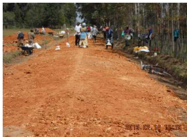
写真11 レヘマ：2月11-15日（8月21日）他の5グループと同じ、国道から村へ続く道の一部130mを補修。
