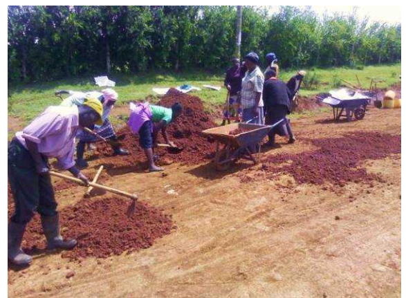
写真 17 キプカレンサウス：7月22-27日、エルドレットの中心部に隣接する住宅地の中の道156mを補修。
