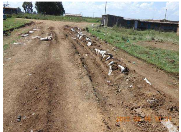
写真 15 チュヤットグループ：6月24-28日 エルドレット近郊のマーケットへのアクセス道路80mを補修。施工に使ったマラム土の質が悪かったこと、雨の後に大型のローリが入ってきたため、新たな轍が生じてしまった。今後、補修を予定している。
