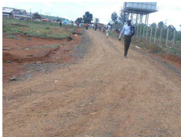
写真 19 エウエロフルマ：8月 12-16 日（8月 30 日）施工後。病院への取り付け道路 110mを補修。
