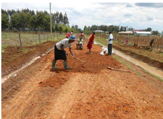
写真9 セリトウェット：4月10-16日（9月3日）湿地に隣接する農道126mを補修。住民からカルバートを寄贈され、交差点に敷設した。
