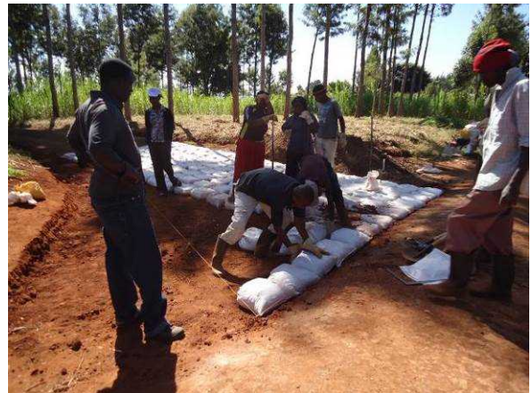
写真23 コモタイコーヒー生産組合（カムチェゲ工 場）2月11-15日（9月5日） メイン道路から集 落へ続く道72mを補修。
