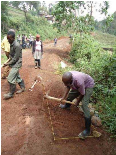
写真22 コモタイコーヒー生産組合（カネケ工場） 1月28日-2月1日（9月5日） 舗装道路から工場 へ続く道路の一部106mを補修。
