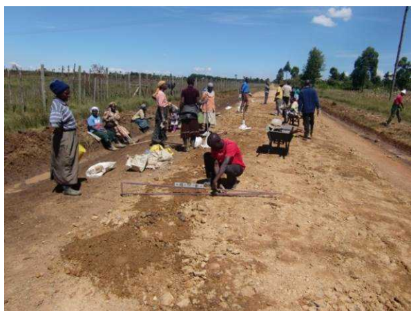
写真5 ジャシヨマレールグループ：2012年12月7- 13日(8月16日) クカダグループと隣接する箇所 112mを整備。
