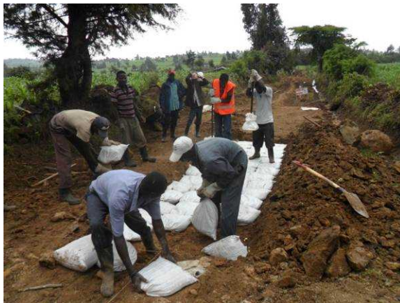
写真 14 オレンゲセ：6月10-14日（9月4日）村から農産物の運搬に使われる農道80mを補修。傾斜があるため、雨水による道の崩壊が激しかった。
