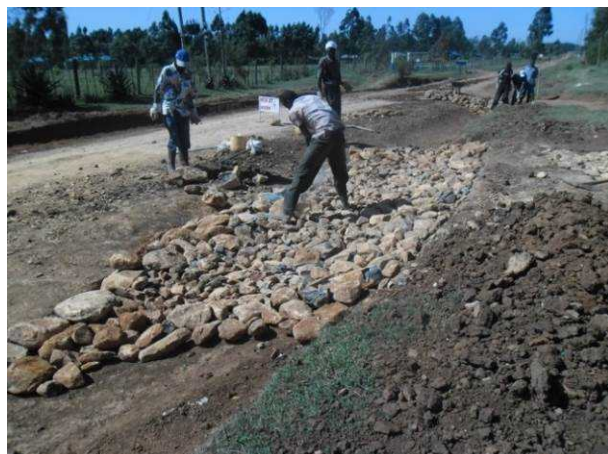
写真6 オアシス：1月8-14日 ジャシヨマレールグル ープに隣接する箇所220mを整備。写真は道の交差部分 に、石を利用して、車両が通行可能な排水路を整備し た。
