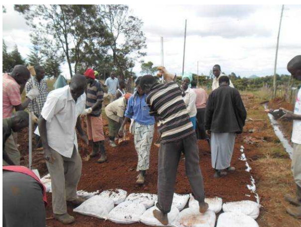
写真10 フォーエバーユース：11月12-16日（7月18日）診療所に続く道113mを補修。
