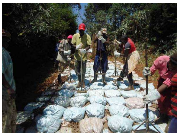
写真 30 ギティリコーヒー生産組合 7 月 15-19 日 ゲートから続く 54mの道を補修。
