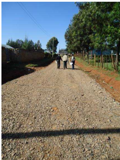
写真 18 キプカレンネノ：8月 5-6 日 施工後。エルドレット市街地に続く教会の前の住宅地の道 115mを補修。
