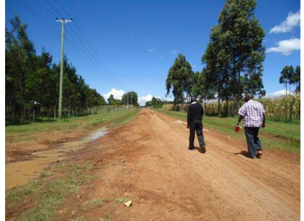
写真 13 ムワトシャ：5月27-31日（8月30日） 施工後。他の5グループと同じ、国道から村へ続く道の一部130mを補修。
