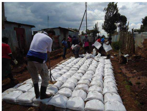
写真 21 スポディアグループ：9月 9-17 日 エルドレット中心部から 4km 程離れた住宅地の中の道を補修。道に 10cm 以上の深さの雨水が溜まり、雨期は通行は不可能となっていた。土のうを 2-4 層重ね、路面をかさ上げた。
