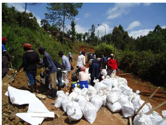
写真8 コマタイコーヒー生産組合 (活動6：セントラル州ギツウングリ県) 1月28日-2月1日(5日間) トレーニング参加者 26名 施工距離 74m (カネケコーヒー工場に続く未舗装農道。 ※上部に見えているのが工場の一部) 側溝整備 120m
