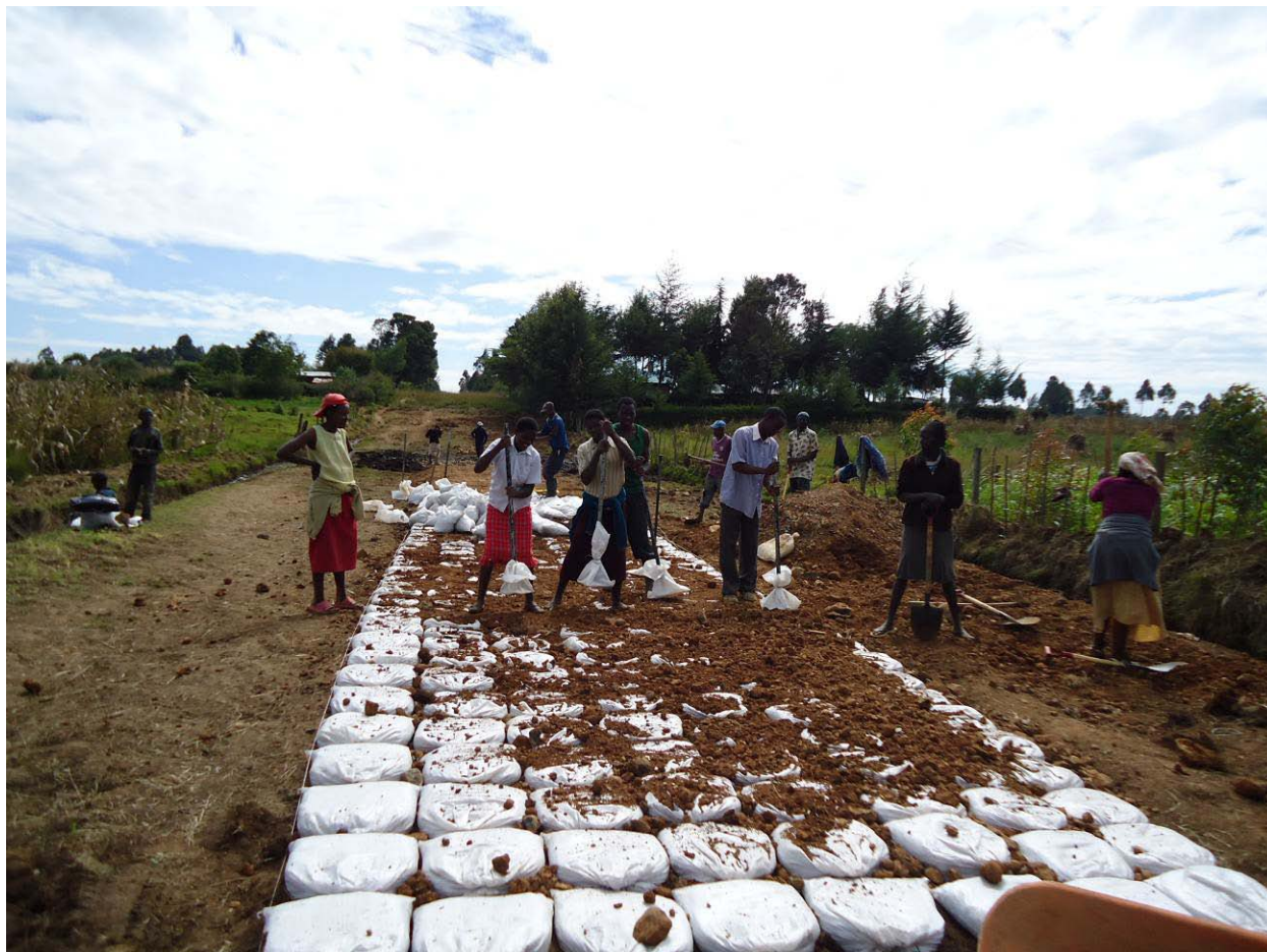
写真3 地元で手に入る材料を使い人力で締め固める「土のう工法」(昨年度事業)
