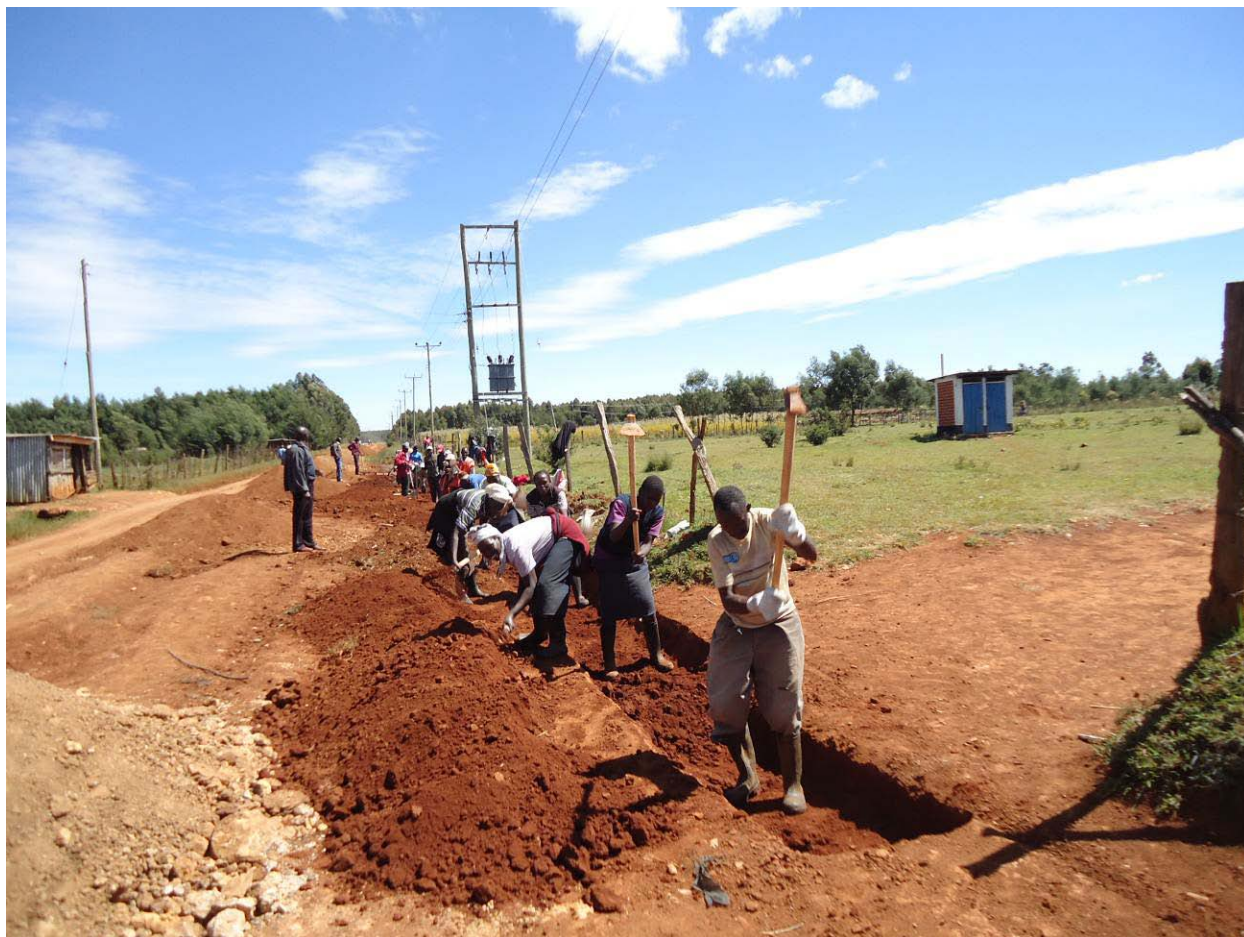
写真2 路面の排水を確保するため、側溝を掘り排水を確保する。
