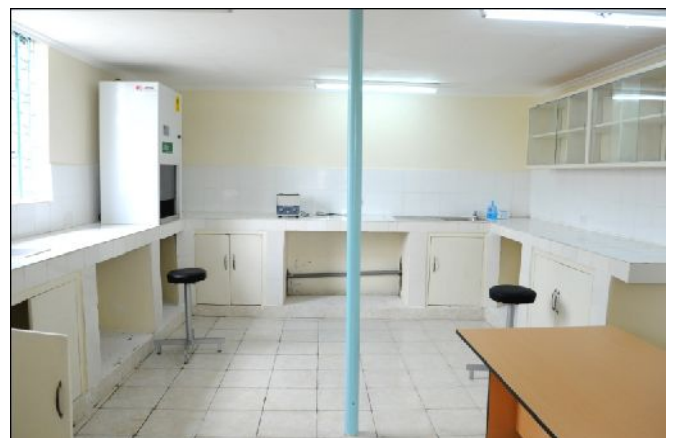
対象コミュニティが受診する保健施設（ナイロビウエスト刑務所保健センター）の検査室の改築
