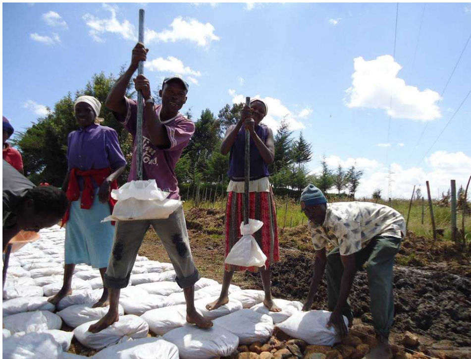
写真3 「土のう」の圧縮：土のうの口を下向きに敷き詰め、コンパクターで10回程度圧縮する。（ワーレン県 クカダグループ）
