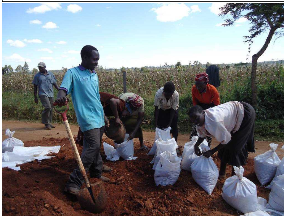
写真 2 「土のう」の準備：プラスチック缶で図ったマラム土を土のう袋につめ、紐で口を閉じる。(エルドレットウエスト県 カプタベグループ)
