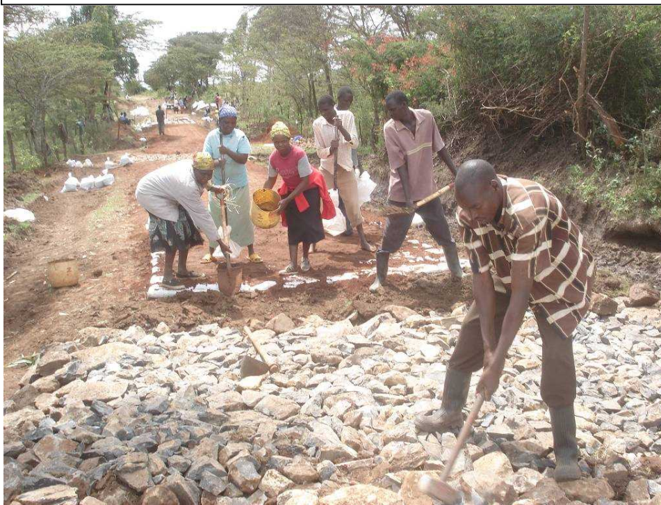
写真4 ドリフトの設置：砕いた石を敷き詰め路面を横切る水の通路を作る。奥では、土のうの隙間をマラム土で埋め表面を圧縮する（エルドレットウエスト県 エペソグループ）
