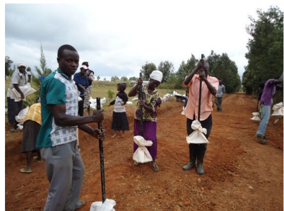
写真5 路面の圧縮
