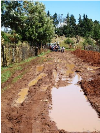
写真1 補修前の農道
