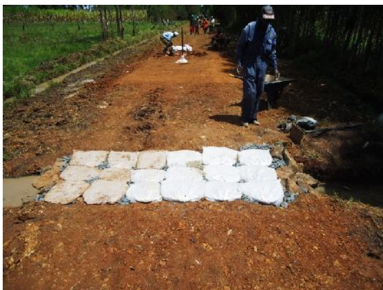
写真4 石を使って設置された水路
