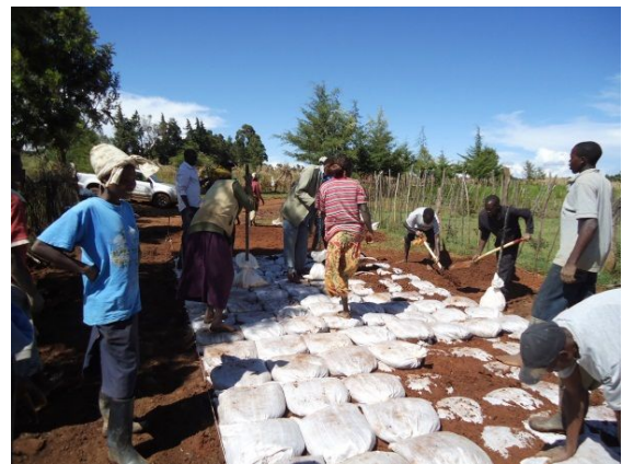
写真3 「土のう」による道直し
