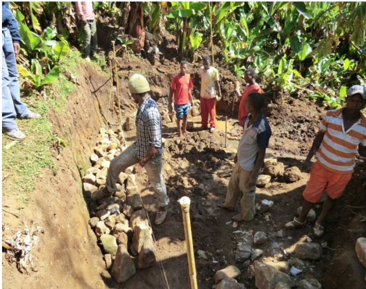
水源保護ボックス建設の様子
