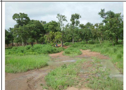
写真8 ダボクリ_その他浸水地点(8月撮影)
