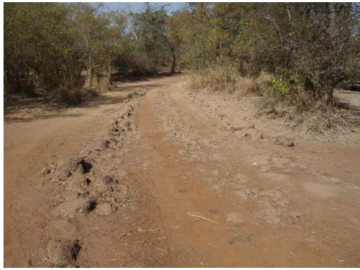
写真1 ウラテンガ_施工前(3月撮影)
