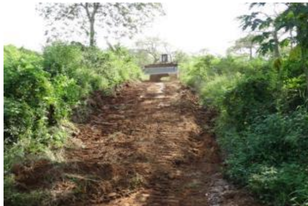
除去地への移動路の造成
