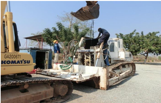
除去機整備作業を指導中の専門家
