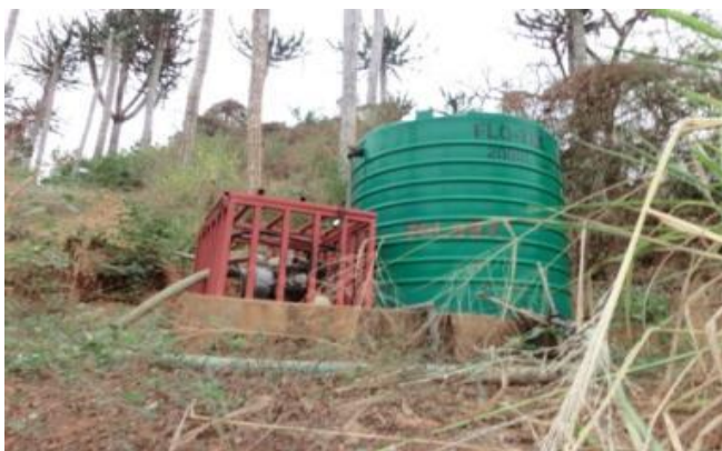
中間地点用ポンプと2000Lタンク
