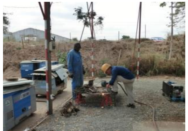
溶接作業を指導中の専門家
