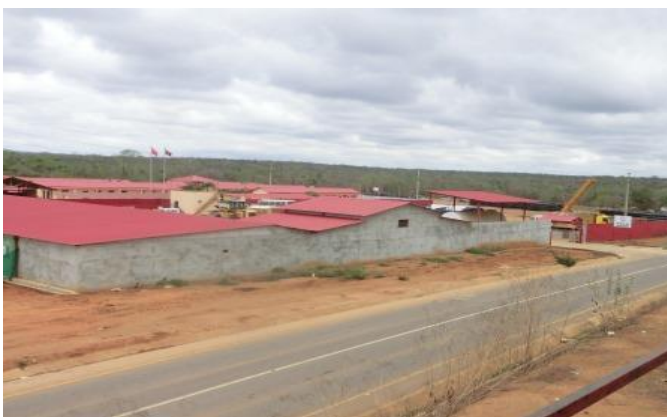
浄水場等の公共施設を建設中
