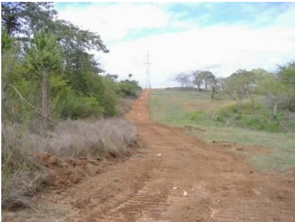
拡幅中の道路
