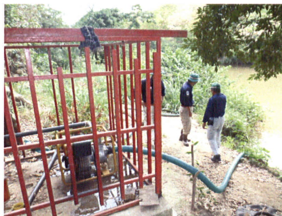
ポンプ及びホース等機材を点検中
