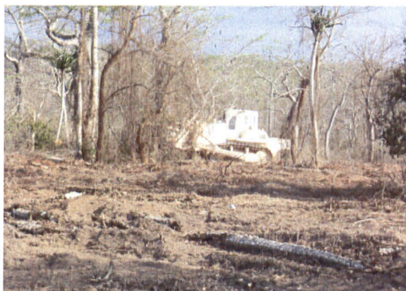
除去中の地雷除去機
