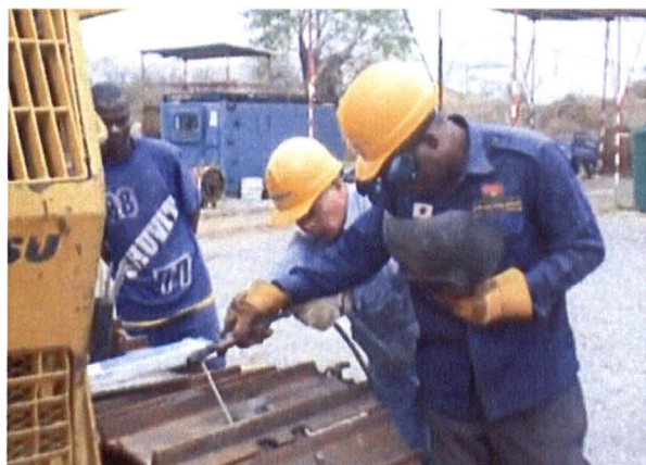
溶接作業を指導中の専門家
