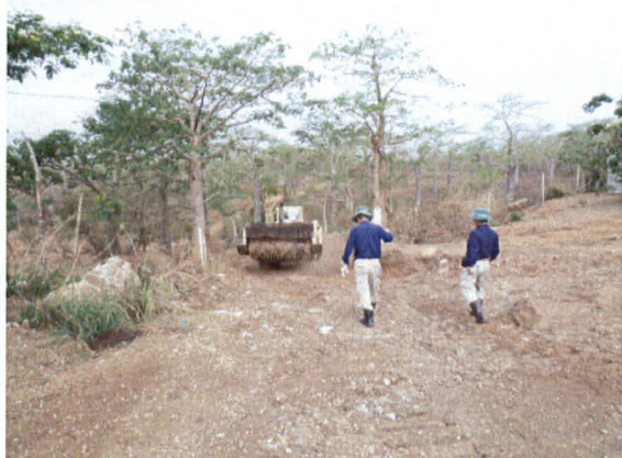
除去地域への道路を造成中
