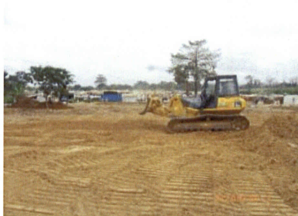
マーケット周辺地域を整備中
