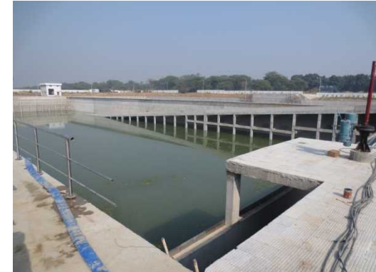
【完成済みの沈砂池(新設)】
