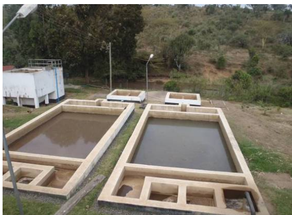
既存浄水場の沈殿池
