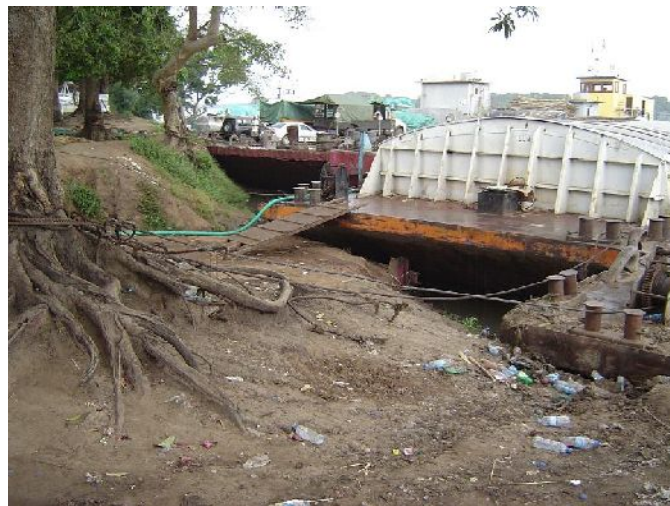
現状の岸壁状況
