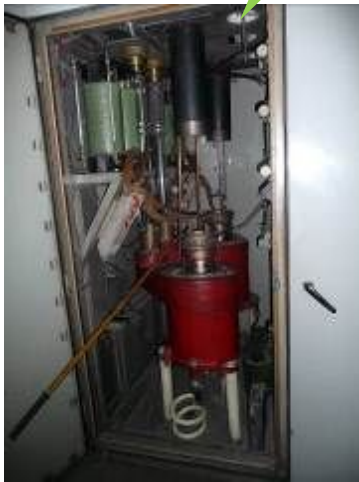
老朽化したファキラバード送信所の送信機
