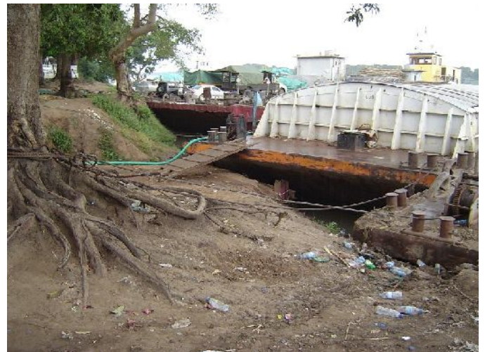
現状の岸壁状況
