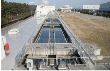
汚水処理施設建設
