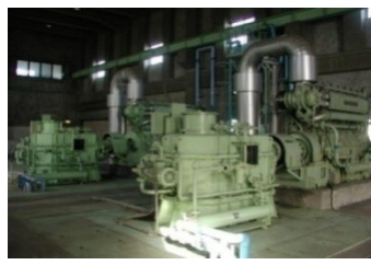
排水ポンプ設置
