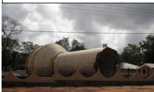
国内紛争により倒壊した給水塔
