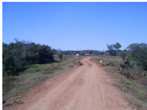
【整備対象道路の現状（未舗装）】
