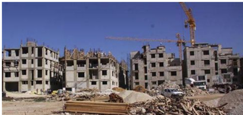
第 1 区画での建設作業現場（2010 年）
