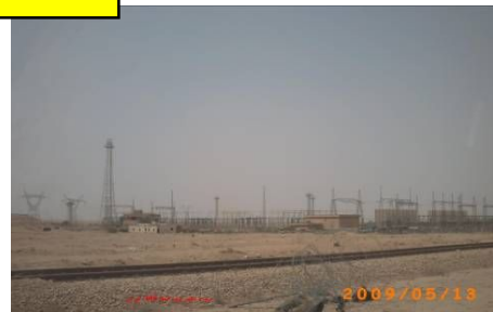
周辺状況 (既存のアルカウム変電所)
