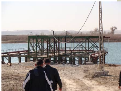
バーシカ・ハムダニヤ地区の既存取水施設
