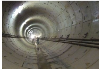
【地下鉄トンネル】
