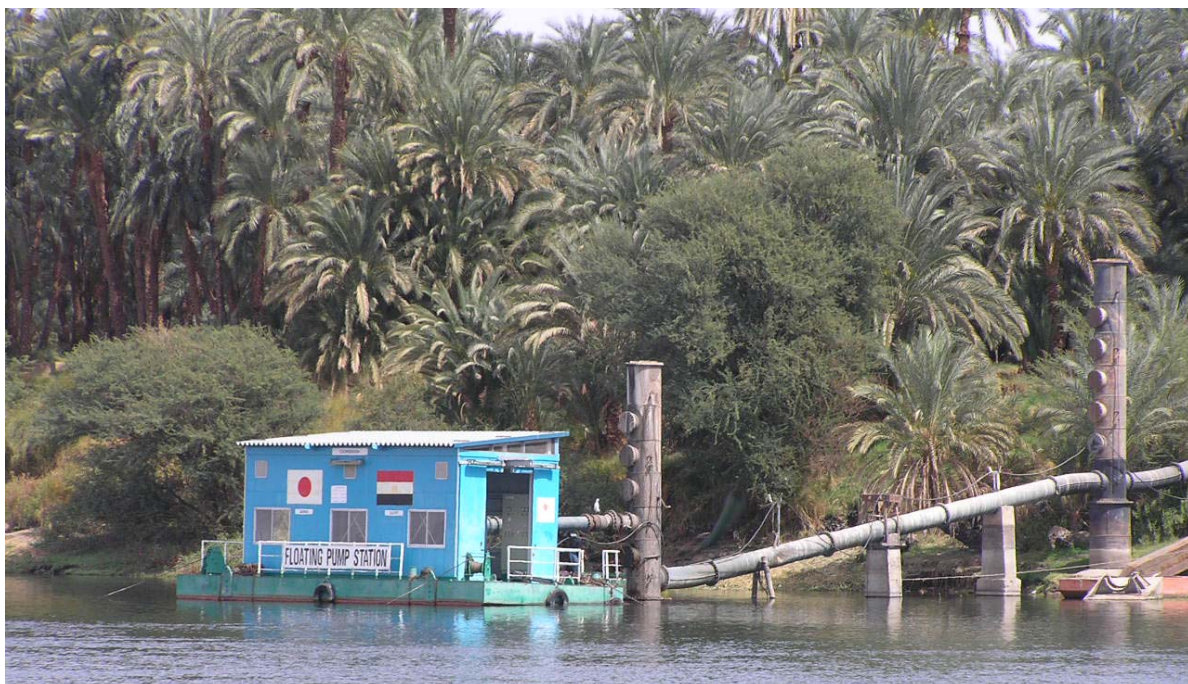
No.22 Sahel Alakaba Kebli ポンプ場
