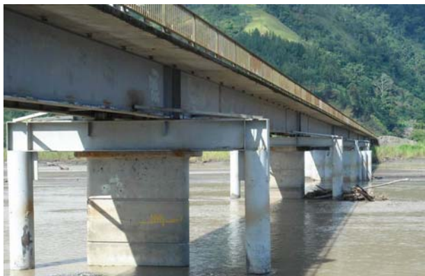
現状 (橋脚が仮補修されている)
