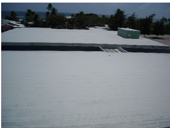
設置候補地のマジュロ国立病院 (新館) 屋上部
