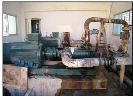
老朽化が激しく水漏れが発生している
