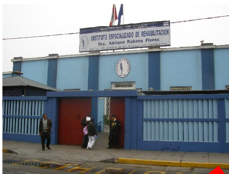
現在の障害者リハビリテーションセンター
