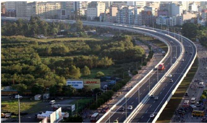
既に環状道路が整備された隣接区間
