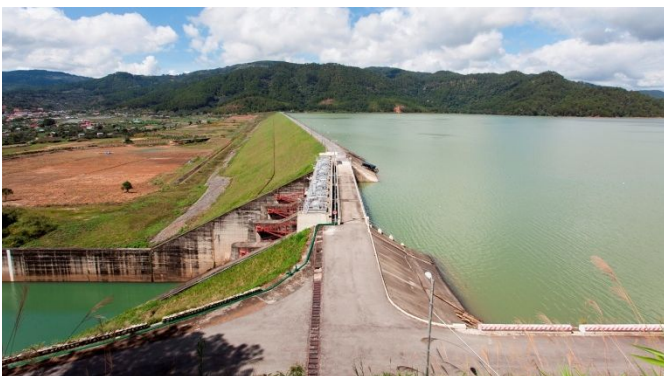
ダニム水力発電所(ダム本体)
