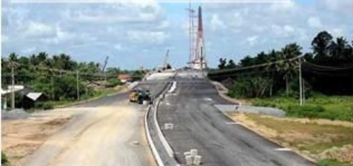
大河に架かる橋梁へのアクセス道路を整備
