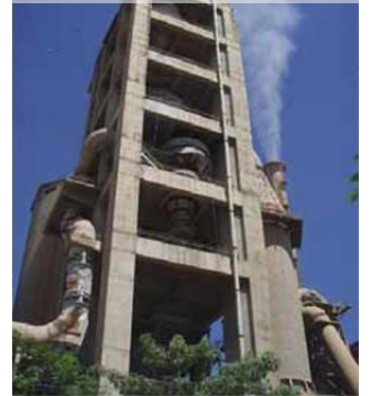
セメント工場の廃熱を有効活用
