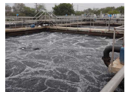
【完成済みのスイカンドラー浄水場(増設)】
