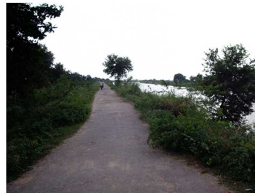
【補強整備された維持管理用道路】
