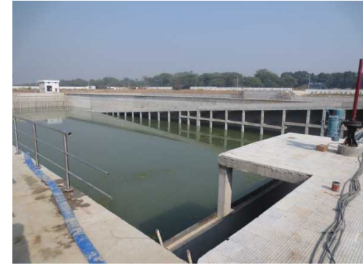
【完成済みの沈砂池(新設)】
