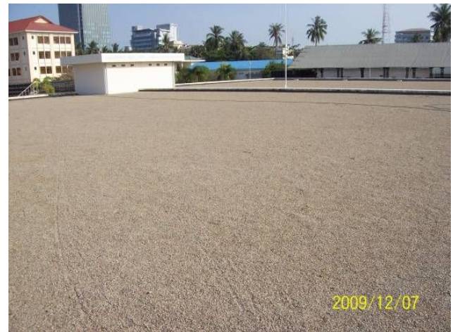
太陽光パネル設置予定の貯水池屋上
