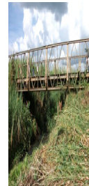
現行の仮設橋
