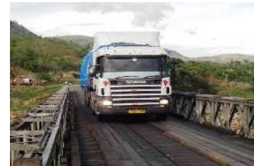
一車線のための現行の橋
